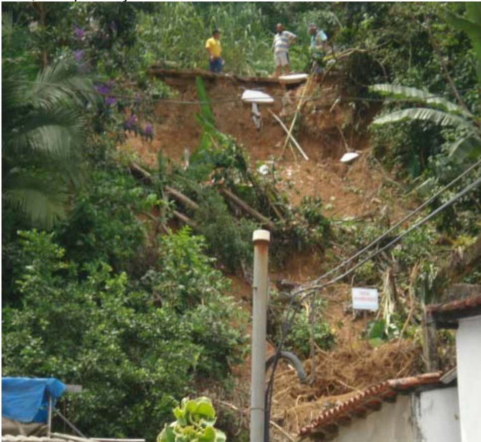
Foto 1: Desmoronamento no morro Peru
