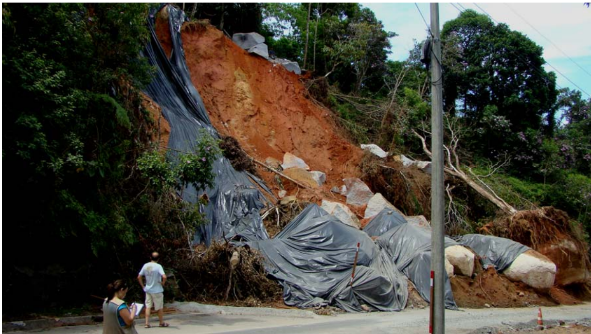
Foto 3: Escorregamento rotacional e queda de blocos na estrada próxima a comunidade Caiçara, no Bairro Trindade.
